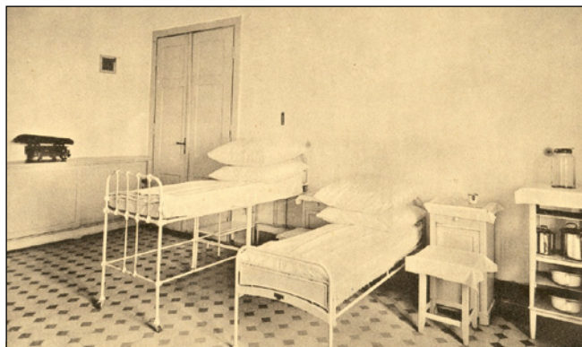
Sala porodowa w Szpitalu przy Karowej. Zdjęcie archiwalne
